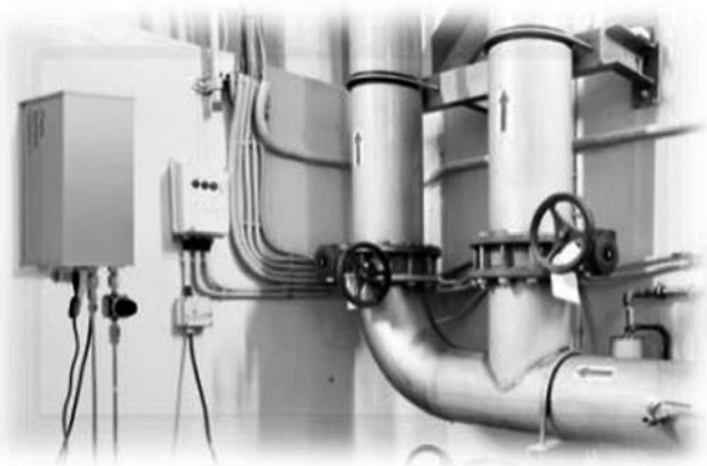
図13：mini CRDS (センサー部を壁面へ取付け)
